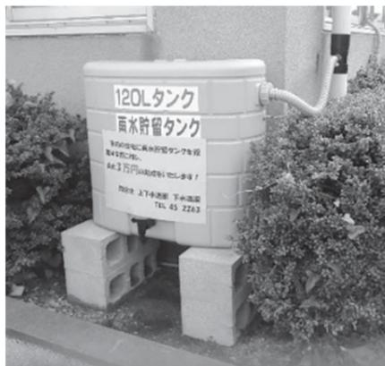
雨水貯留タンクとは雨水を建物の雨どいを通じて集め、一時的に貯めておく設備のことです。
