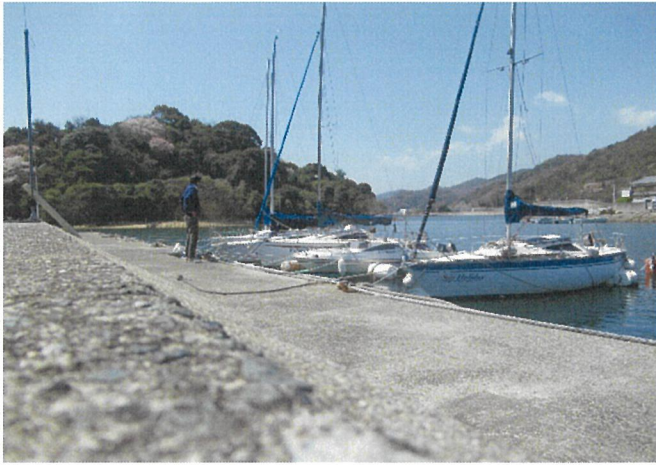
施設内の設備点検
