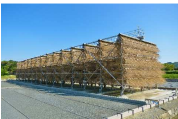
兵庫県立海浜公園内の「塩の国」にある枝条架
