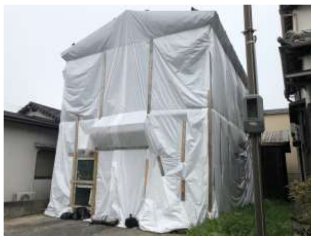
応急措置実施後
