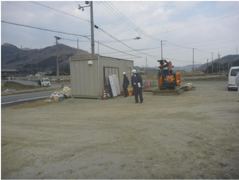
(作業現場事務所)
