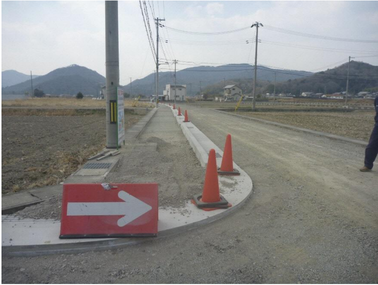
(舗装部：西側より)
