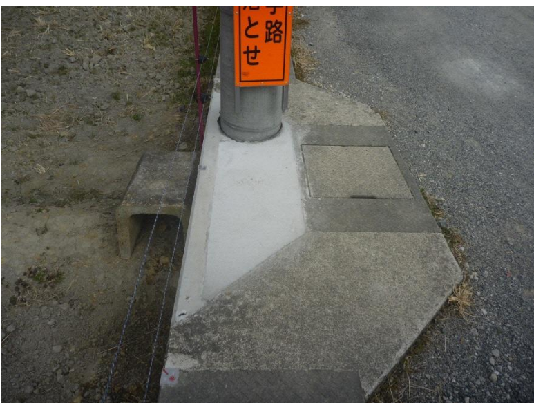
(擁壁工完成状況)
