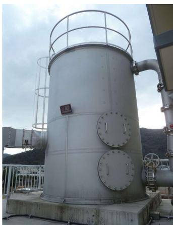
写真 6-1 エアレーション（曝気）設備
