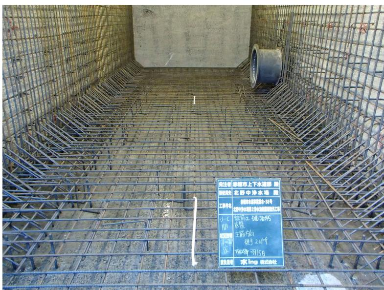
写真6-7 耐震補強の例（北野中浄水場浄水池（第2系））
