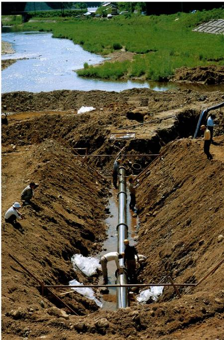
写真 6-3 集水埋渠の施工事例
