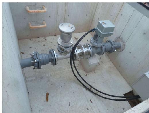
写真 6-9 緊急遮断弁の設置例
