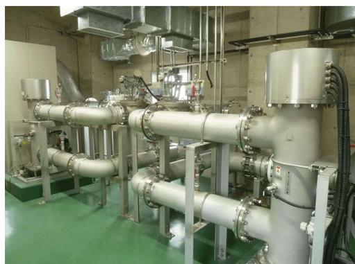
写真 6-2 紫外線処理設備
