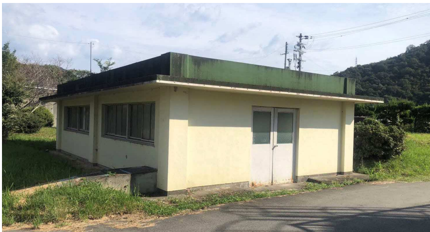
北野中浄水場送りポンプ室
