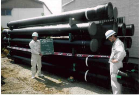
【水道管更新工事状況写真】
