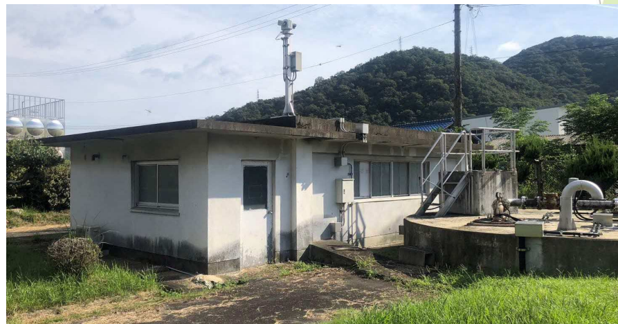
坂越送りポンプ室
