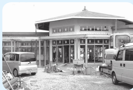
建設中の赤穂幼稚園
