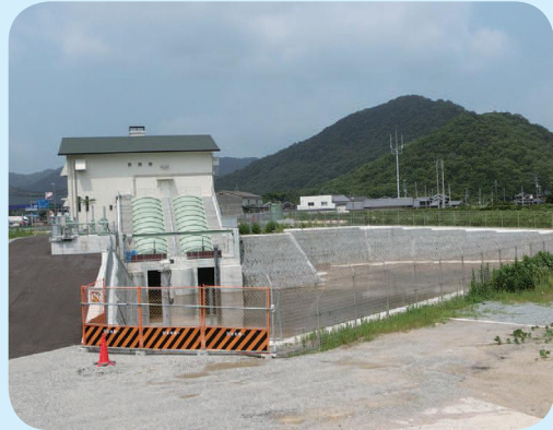
有年ポンプ場
