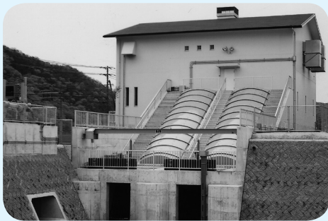
有年ポンプ場
