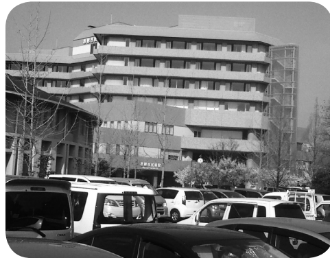
駐車場も整備する赤穂市民病院
