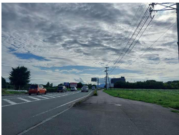
第二原水工業団地周辺(現在2車線を6車線化予定)
