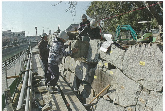
修理を行っている二之丸東側の石垣
