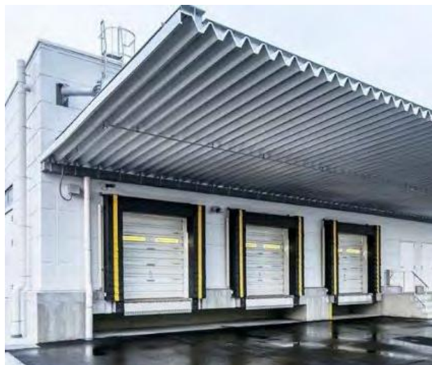
【先行事例】写真 3-1 ドックシェルター
